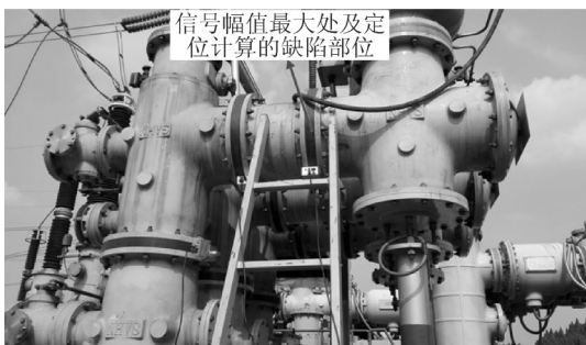
图2 220 kV 缺陷盆式绝缘子特高频测点和放电源位置
